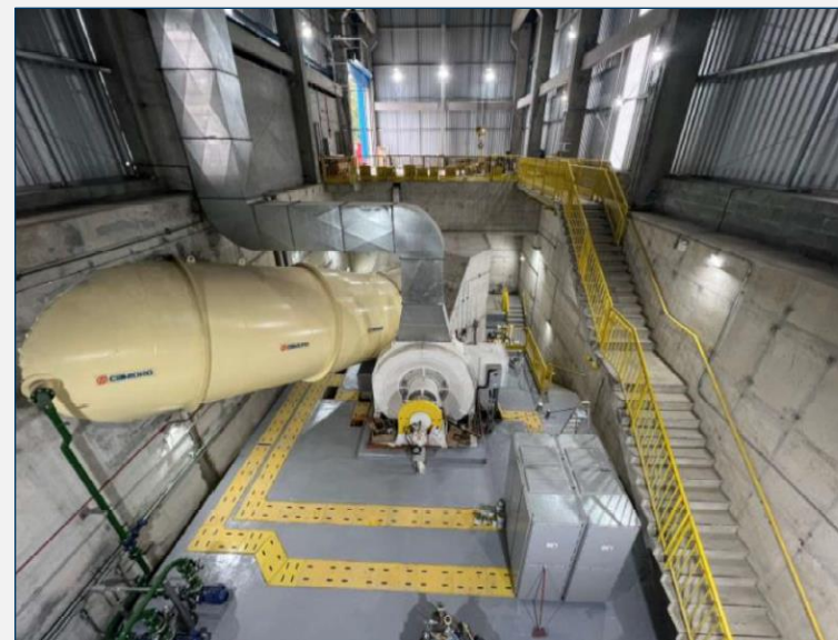
CGH Cascata em obras, previsão de conclusão para Dezembro/2023.
