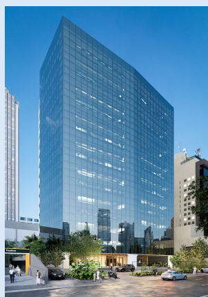
Citadel I Prédio Retrofitado (Jul'26) 1
