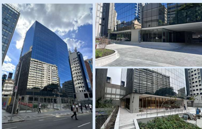
Citadel I Prédio Retrofitado (Jul'26) 1
