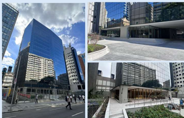
Citadel I Prédio Retrofitado (Jul'26) 1
