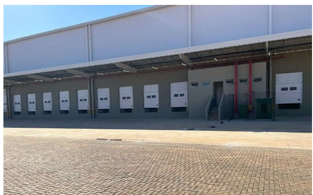
Docas e sanitários do galpão.
