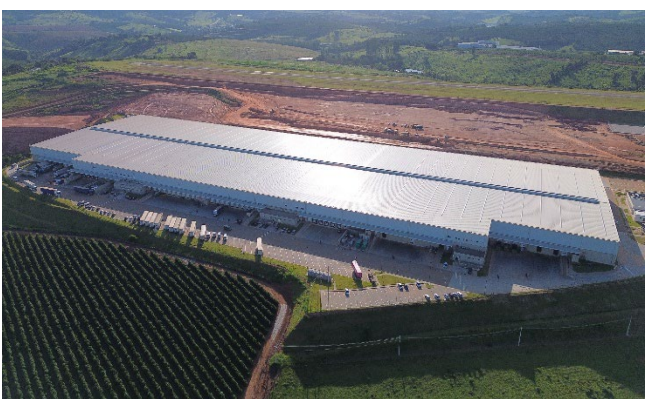
Docas e circulação do condomínio, com sinalização horizontal concluída.
