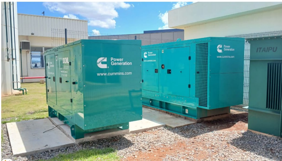
Instalação do novo gerador e painel QTA.
