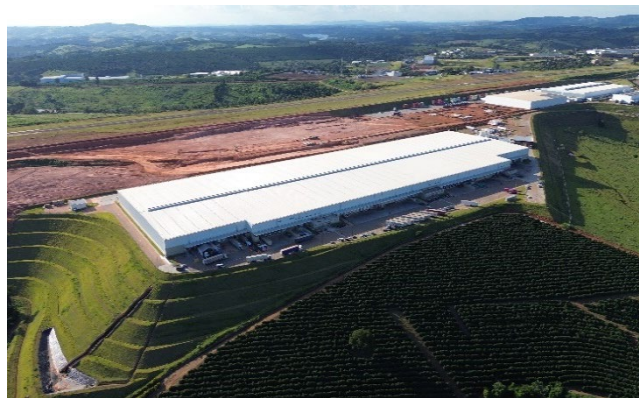
Imagem aérea do empreendimento.
