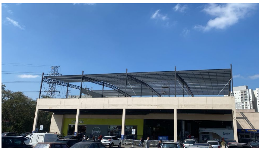
Foto: Construção do shell da Smart Fit no Shopping Bonsucesso.
