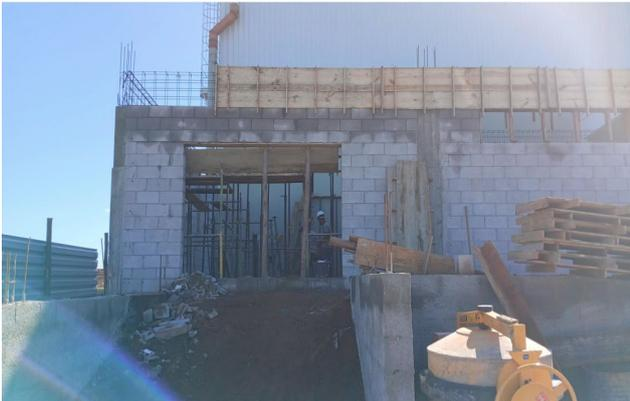
Alvenaria do térreo e estrutura do pavimento superior.
