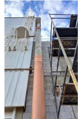
Montagem de formas e escoramentos das estruturas do pavimento superior e adequação da rede pluvial.
