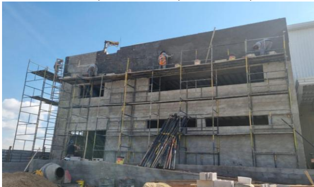
Execução de chapisco, emboço e reboco da fachada; execução de rede de esgoto e fechamento de valas; contrapiso e reboco internos.
