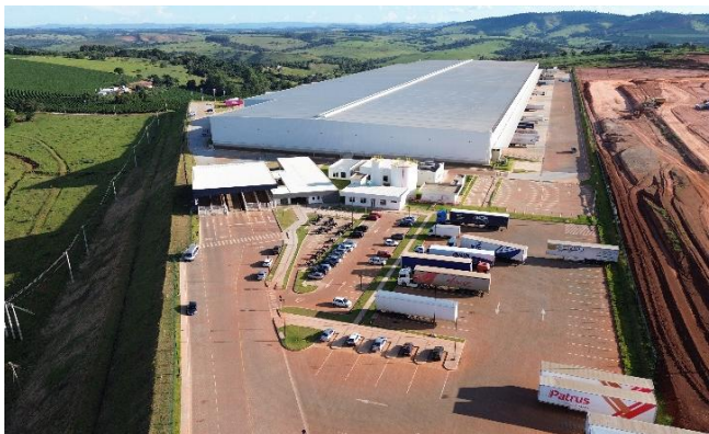
Imagem aérea do empreendimento.
