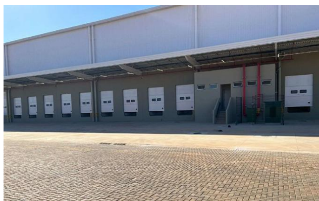
Docas e sanitários do galpão.
