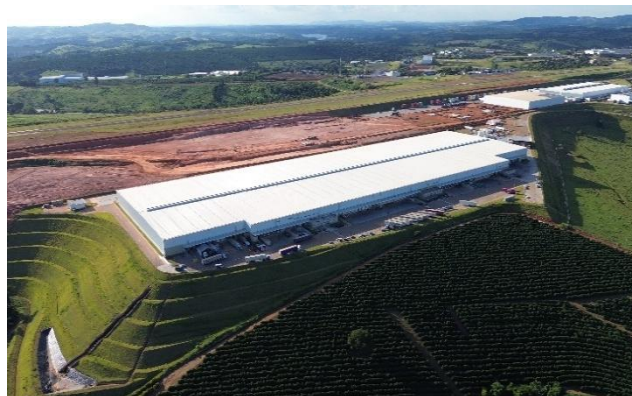
Imagem aérea do empreendimento.
