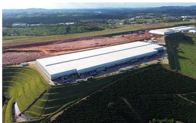
Imagem aérea do empreendimento.
