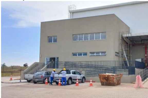
Fachadas frontal e lateral; execução do corrimão da rampa externa; instalação dos forros.
