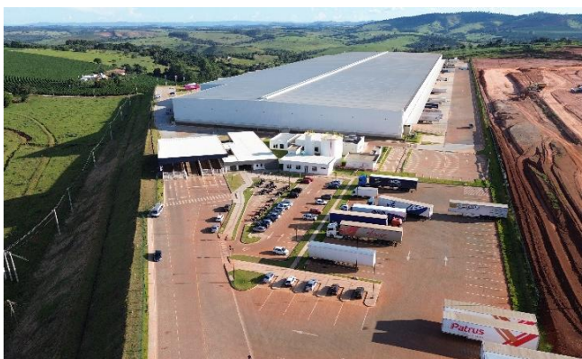
Imagem aérea do empreendimento.
