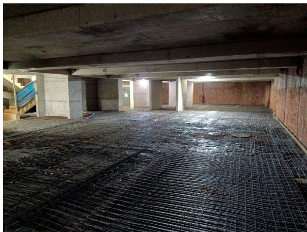
5º Subsolo – Armação do piso em execução.
