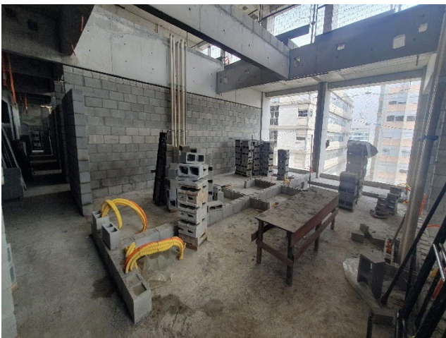
15º Pavimento (Unid. Residenciais) – Alvenaria em execução.
