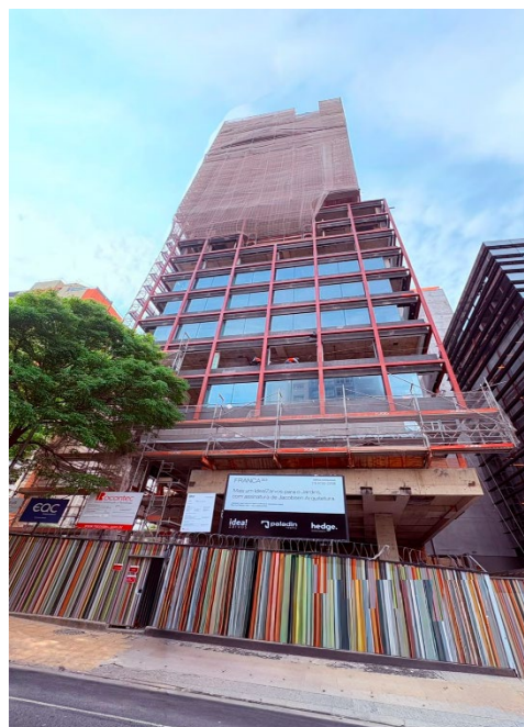
Fachada Av. 9 de julho – Caixilhos instalados.
