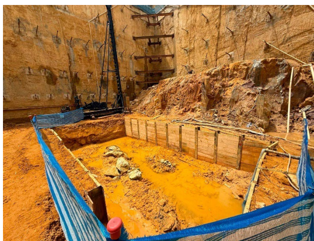
Contenção provisória para escavação de bloco de fundação.
