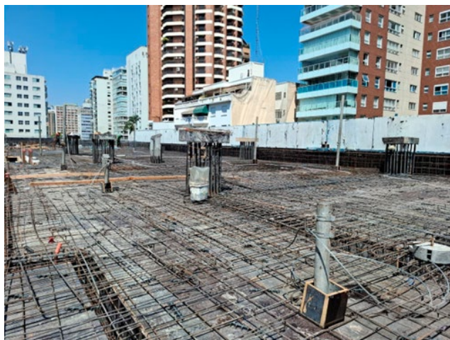
5º pavimento - armação da laje em execução.
