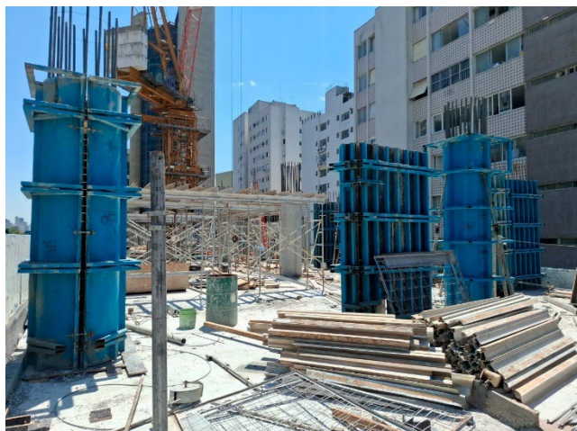
Pilares e cimbramento do 7º pavimento em execução.
