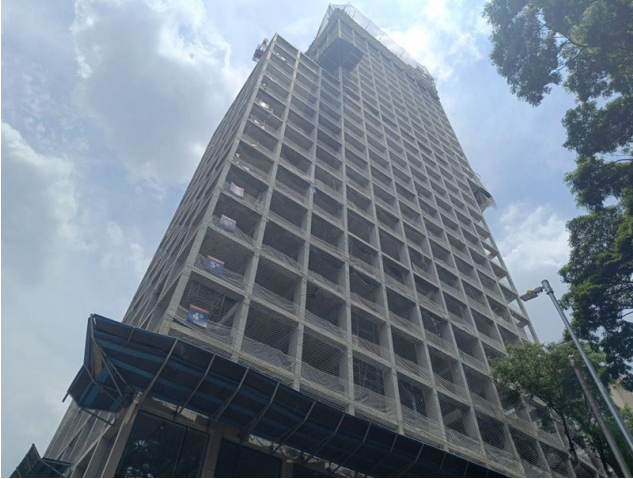
Vista Fachada - Rua Antônio Carlos.
