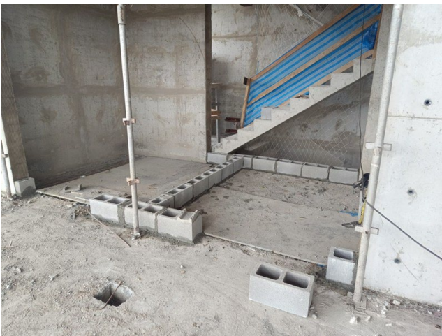
Alvenaria em execução.
