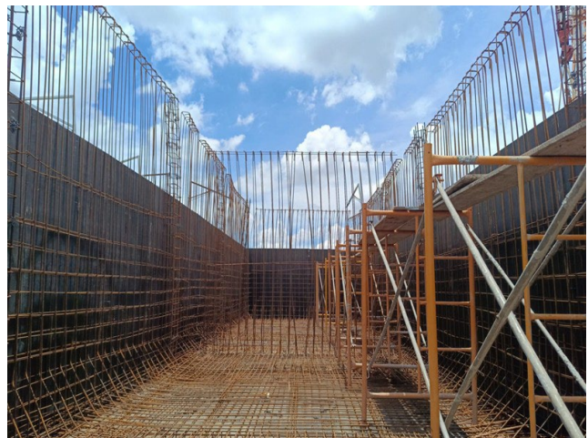
Armação de piso e paredes em execução.
