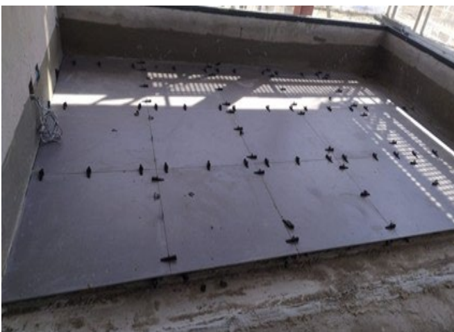
16º Pavimento (unid. Residencial) - Instalação de piso em execução.
