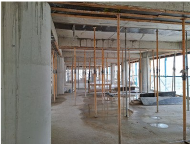
10º Pavimento – Escoramento de Laje
