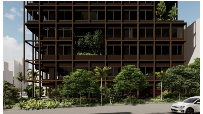
Detalhe Fachada Ativa
