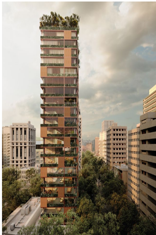
Fachada Rua dos Pinheiros. Fonte: Hedge, Paladin, Idea Zarvos e Studio MK27.
