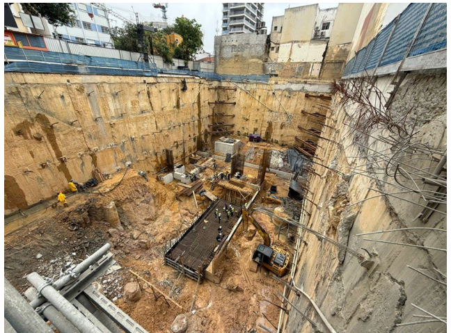
Armação de bloco de fundação (dez/25).
