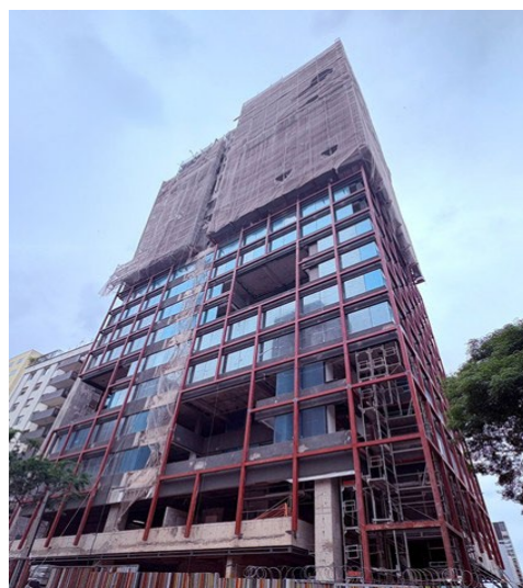
Fachada Av. Alameda Franca – Caixilhos instalados.
