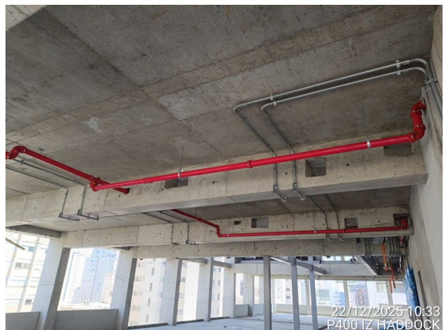
Conj. Corporativo - Tubulação de incêndio em execução.
