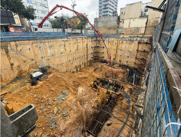
Concretagem da primeira etapa de blocos de fundação (out/25).
