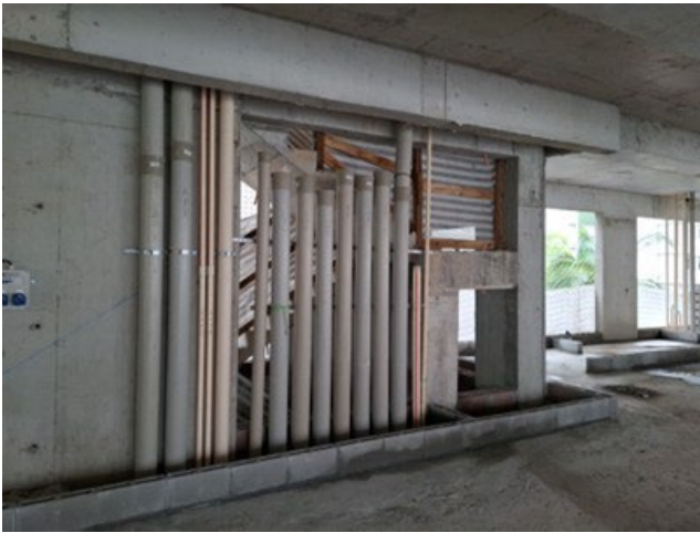
4º Pavimento – Tubulação hidráulica em execução.
