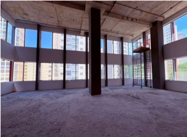
4º pavimento (conj. Corporativo) - Pintura em execução.
