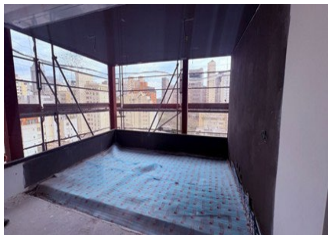
16º Pavimento (unid. Residencial).
