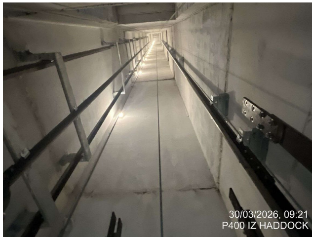
Elevador residencial 2 - Montagem da estrutura.
