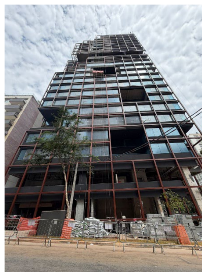
Fachada Av. Alameda Franca – Caixilhos instalados.
