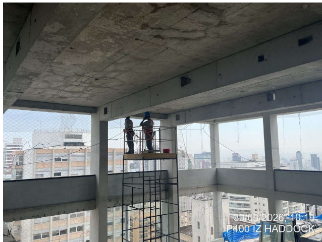
28º pavimento - Caixilho.
