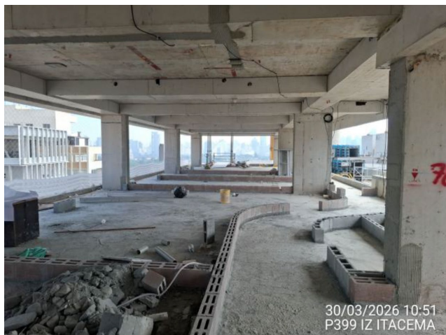
15º Pavimento – Marcação de alvenaria.
