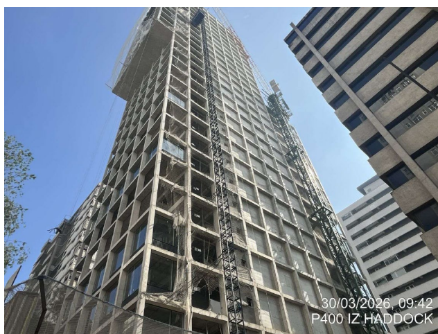
Vista Fachada - Rua Antônio Carlos.
