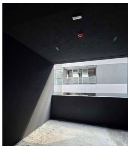
4º Pavimento (conj. Corporativo) - Execução de textura na área técnica.
