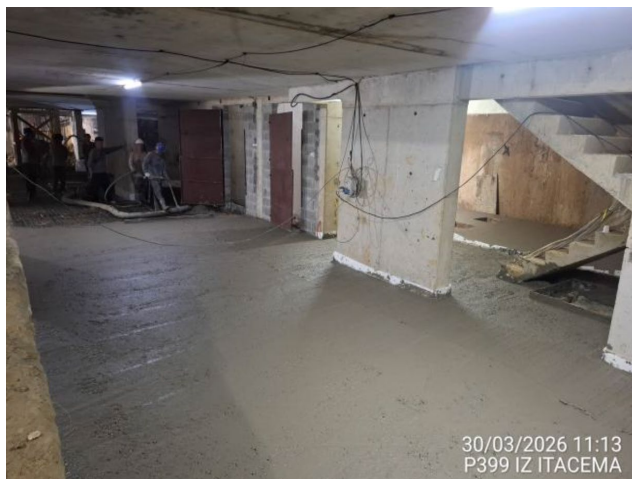
5º Subsolo – Concretagem do piso.
