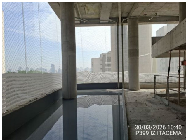
11º Pavimento – Teste de impermeabilização.
