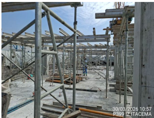
21º pavimento – Montagem de estrutura do 22º pav.
