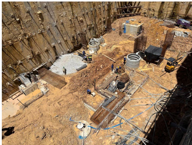
Visão geral da obra (fev/26).
