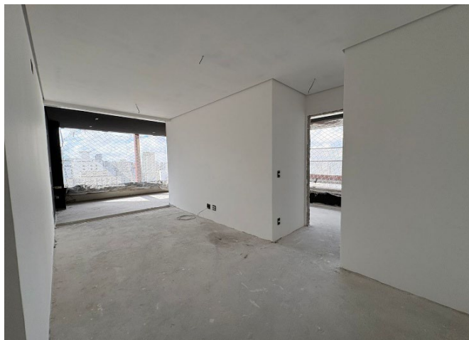
18º pavimento (unid. Residencial) - Pintura em execução.
