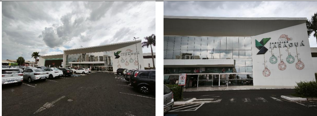
FOTOS DA FACHADA DO IMÓVEL
