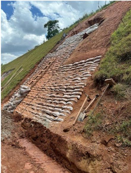
Foto de recuperação talude.
