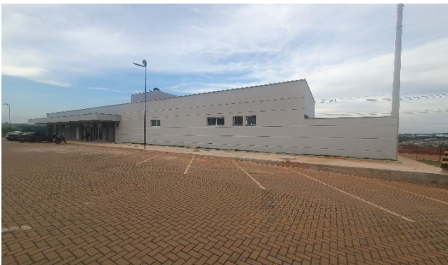
Foto obra restaurante Citlog Sul de Minas.
