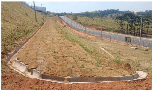
Instalação do sistema de drenagem no talude.
