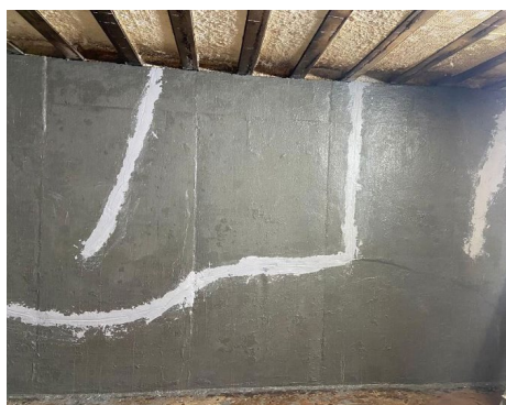
Execução dos serviços de impermeabilização.
