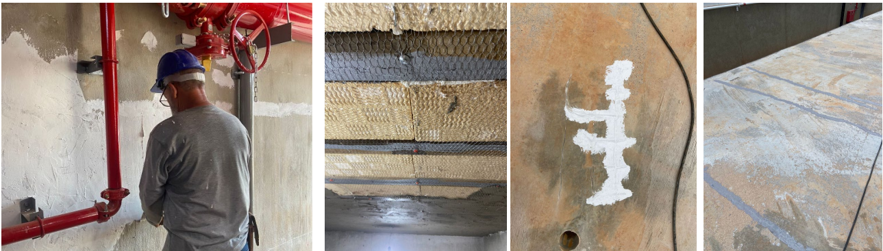
Execução dos serviços de impermeabilização.
