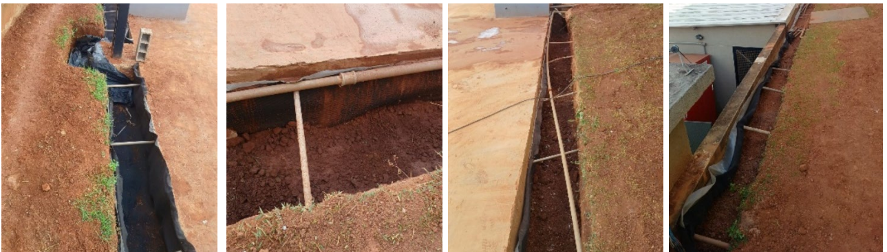
Execução dos serviços de impermeabilização.
