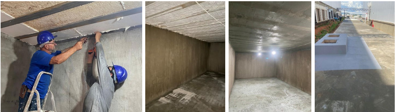
Execução dos serviços de impermeabilização.
