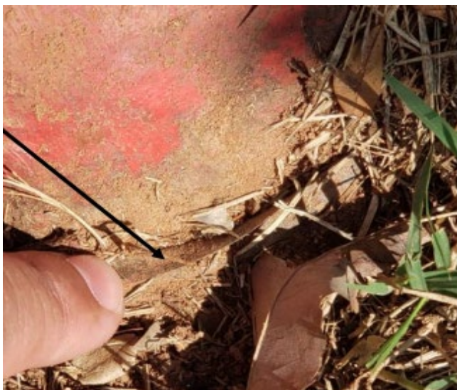
Falta de aderência na fita anticorrosiva.
