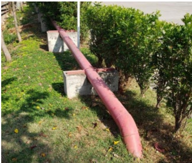
Rede principal de incêndio danificada.
