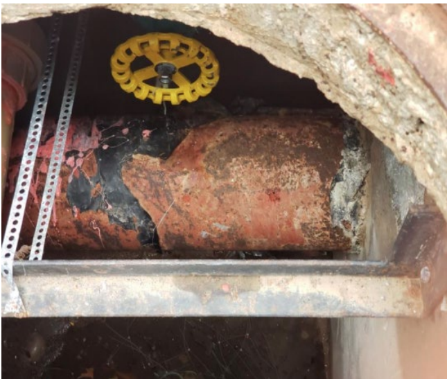
Rede principal de incêndio substituída.
