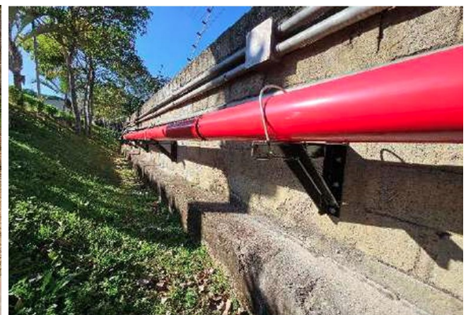
Nova rede de abastecimento de incêndio.
