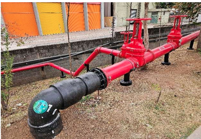
Nova rede de abastecimento de incêndio.
