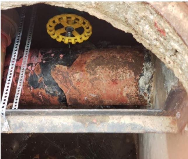
Rede principal de incêndio substituída.
