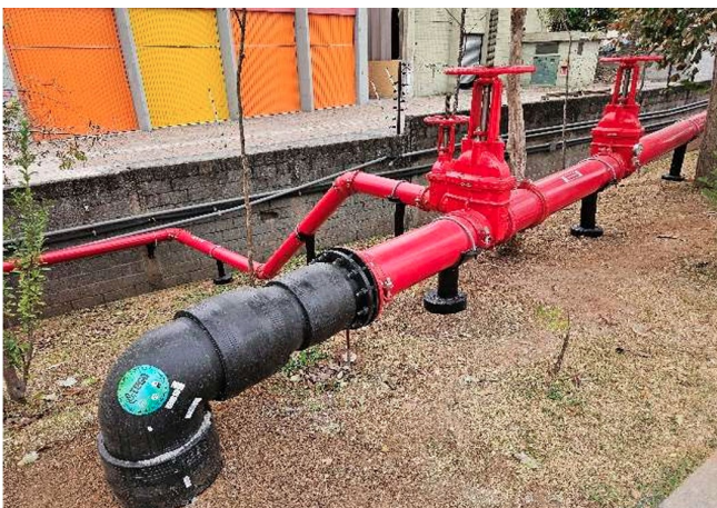
Nova rede de abastecimento de incêndio.
