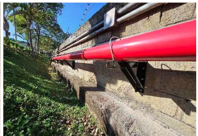
Nova rede de abastecimento de incêndio.
