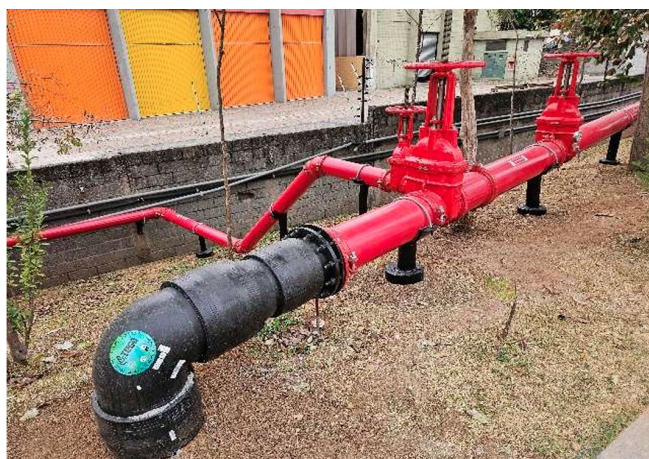
Nova rede de abastecimento de incêndio.
