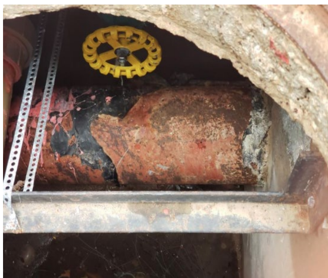
Rede principal de incêndio substituída.
