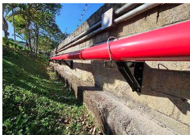
Nova rede de abastecimento de incêndio.
