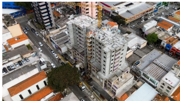
Imagem Aérea – Visão Geral (jul/25) – Lado A e lado B com a alvenaria estrutural no 11º pavimento.
