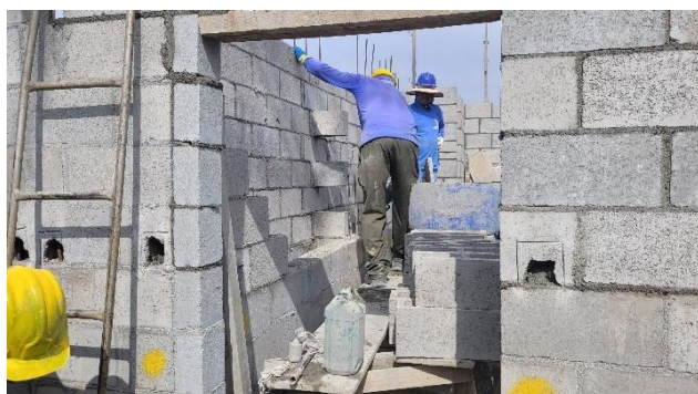
Torre Lado A – Alvenaria estrutural 15º pavimento.
