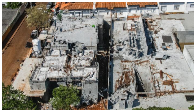
Imagem Aérea – Visão Geral (set/25) – Concretagem da laje do 1º pavimento da Torre Residencial Lado A finalizada e Lado B em execução.
