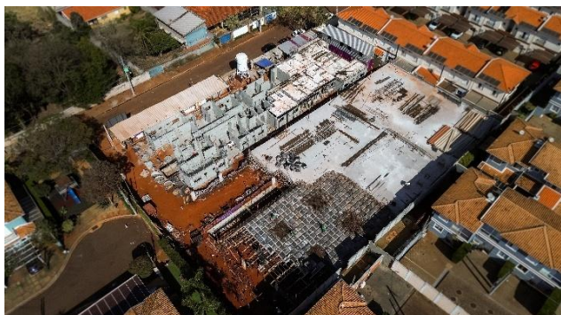
Imagem Aérea – Visão Geral (ago/25) – Preparação da laje do Bloco Garagem e alvenaria estrutural do térreo da Torre Residencial em execução.
