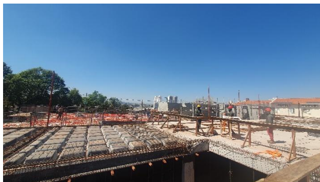
Bloco Garagem – Preparação para concretagem da laje.
