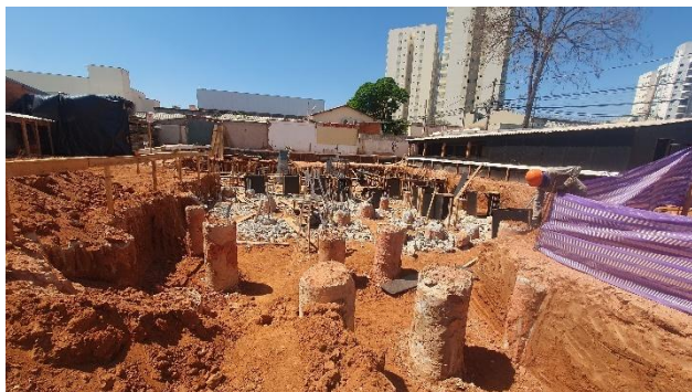
Execução de arrasamento das estacas da Torre Residencial.
