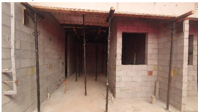
Torre Residencial – Alvenaria do térreo e escoramento da laje do 1º pavimento.
