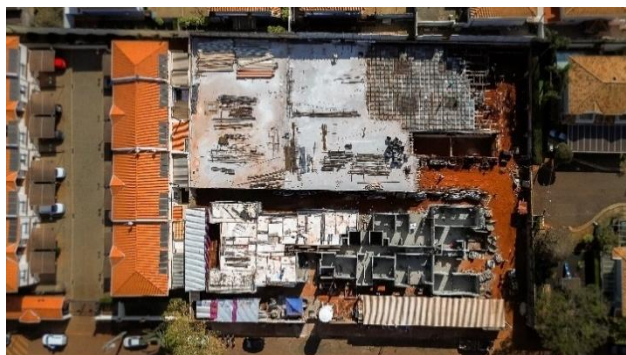
Imagem Aérea – Visão Geral (ago/25) – Preparação da laje do Bloco Garagem e alvenaria estrutural do térreo da Torre Residencial em execução.
