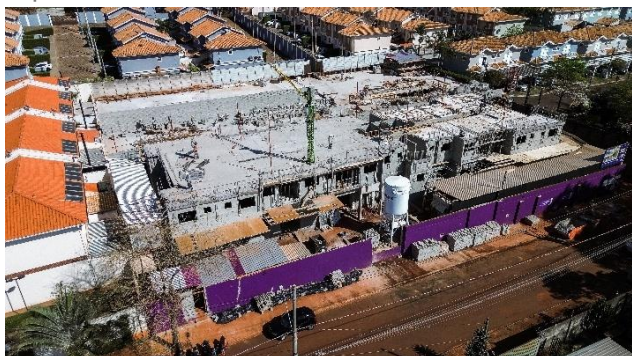
Imagem Aérea – Visão Geral (set/25) – Concretagem da laje do 1º pavimento da Torre Residencial Lado A finalizada e Lado B em execução.
