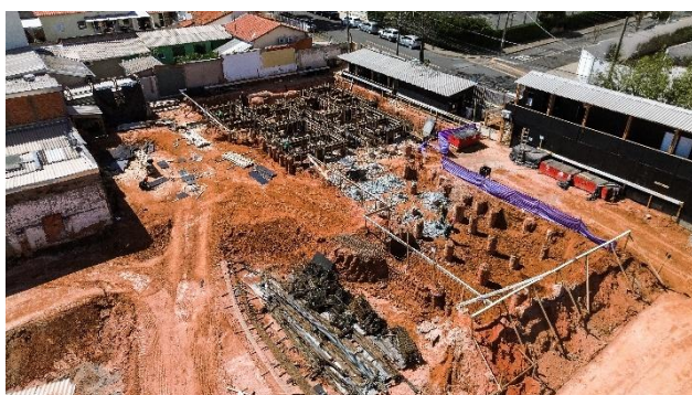
Imagem Aérea – Visão Geral (set/25) – Execução da fundação da Torre Residencial.
