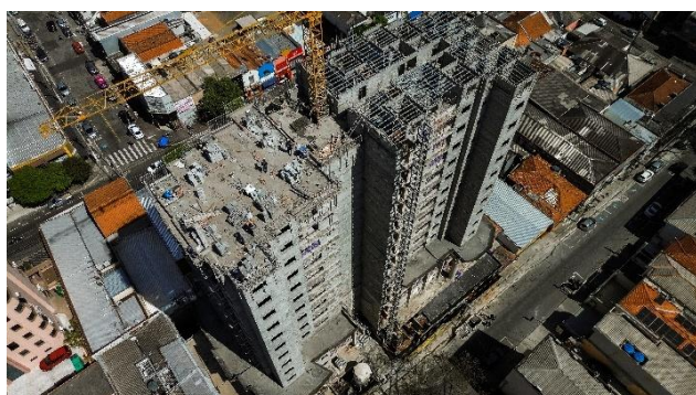
Imagem Aérea – Visão Geral (set/25) – Lado A alvenaria estrutural 15º pavimento e Lado B laje do 16º pavimento.
