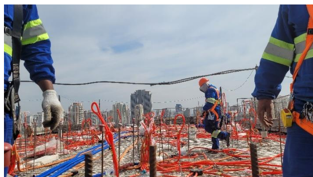
Torre Lado B – Conduítes laje 16º pavimento.
