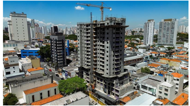
Imagem Aérea – Visão Geral (out/25) – Lado B com a alvenaria estrutural no 16º pavimento e lado A no 15º pavimento.
