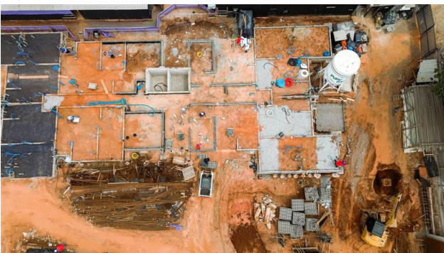
Imagem Aérea – Visão Geral (dez/25) – Preparação da concretagem do térreo da Torre Residencial.
