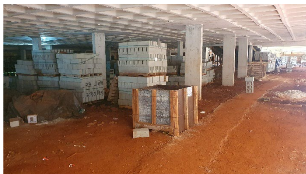
Bloco Garagem – Armazenamento de materiais no térreo e execução dos armários de alvenaria do 1º pavimento.
