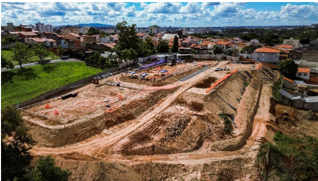
Imagem Aérea – Visão Geral (nov/25) – Execução da fundação.
