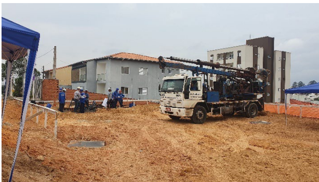
Torre Residencial (out/25) – Preparação para a execução de fundação profunda.
