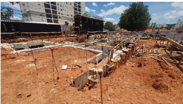
Torre residencial – Execução da fundação.
