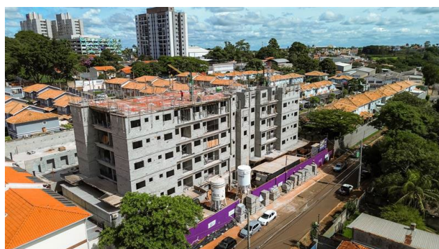
Imagem Aérea – Visão Geral (dez/25) – Preparação para a concretagem da laje do 6º pavimento da Torre Residencial Lado A e Lado B na alvenaria estrutural do 5º pavimento em execução.
