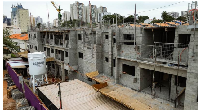
Imagem Aérea – Visão Geral (out/25) – Preparação da laje da Torre Residencial para concretagem.
