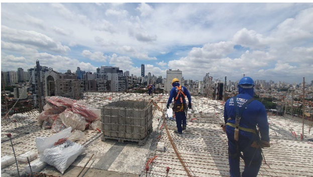
Torre Residencial – Preparação da laje para concretagem e início da alvenaria estrutural.
