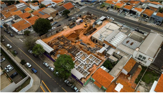
Imagem Aérea – Visão Geral (out/25) – Execução da fundação da Torre Residencial.
