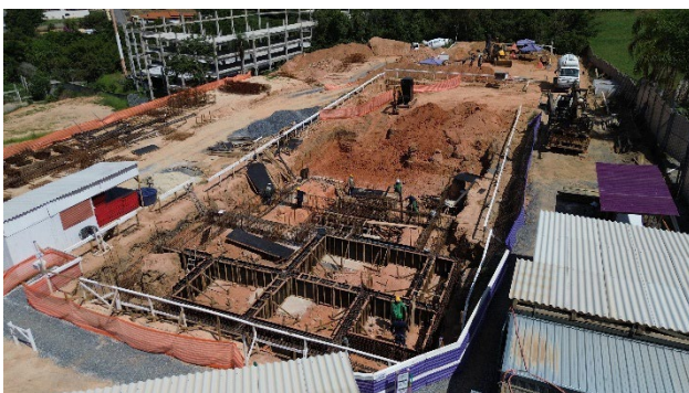
Imagem Aérea – Visão Geral (dez/25) – Preparação para concretagem dos baldrames da área de lazer.
