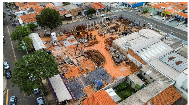
Imagem Aérea – Visão Geral (dez/25) – Preparação da concretagem do térreo da Torre Residencial.
