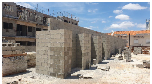
Bloco Garagem – Armazenamento de materiais no térreo e execução dos armários de alvenaria do 1º pavimento.
