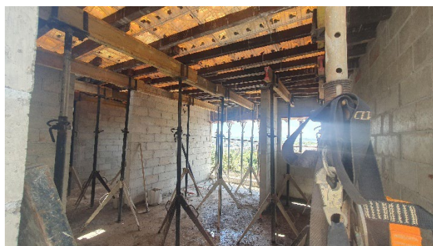
Torre Residencial (nov/25) – Preparação da laje piso do 4º pavimento e instalações em execução.
