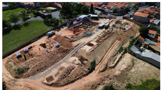
Imagem Aérea – Visão Geral (dez/25) – Preparação para concretagem dos baldrames da área de lazer.
