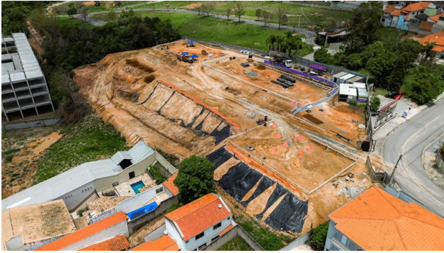
Imagem Aérea – Visão Geral (out/25) – Execução da terraplenagem.
