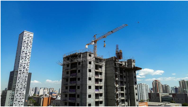
Imagem Aérea – Visão Geral (out/25) – Lado B com a alvenaria estrutural no 16º pavimento e lado A no 15º pavimento.
