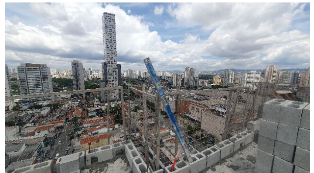
Torre Residencial – Preparação da laje para concretagem e início da alvenaria estrutural.
