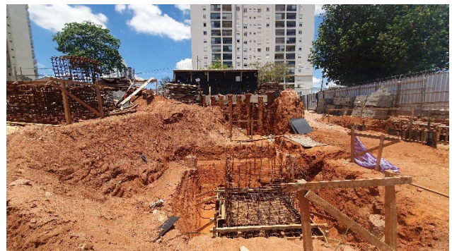
Edifício Garagem – Arrasamento de estacas.
