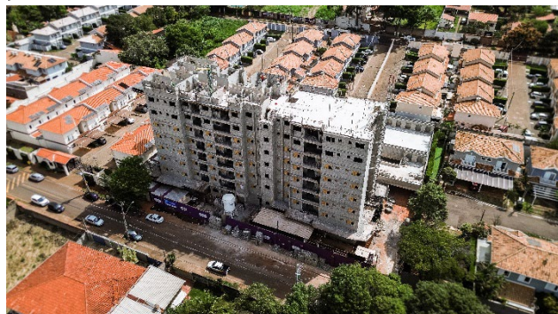
Imagem Aérea – Visão Geral (mar/26) – Execução da alvenaria estrutural do 8º pavimento lado A.
