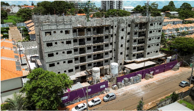
Imagem Aérea – Visão Geral (jan/26) – Execução da alvenaria estrutural do 6º pavimento.
