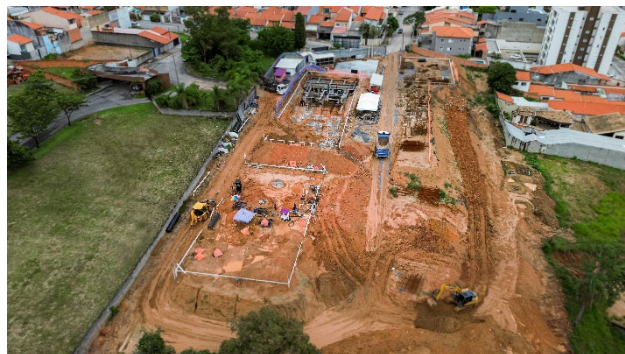
Imagem Aérea – Visão Geral (jan/26) – Execução da fundação da torre residencial e concretagem parcial da área de lazer.
