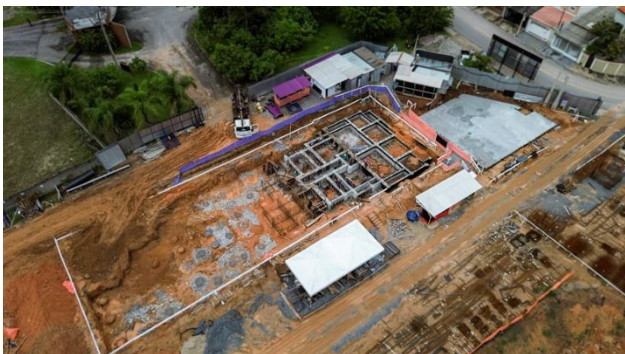
Imagem Aérea – Visão Geral (jan/26) – Execução da fundação da torre residencial e concretagem parcial da área de lazer.
