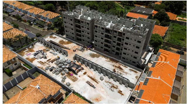
Imagem Aérea – Visão Geral (jan/26) – Execução da alvenaria estrutural do 6º pavimento.
