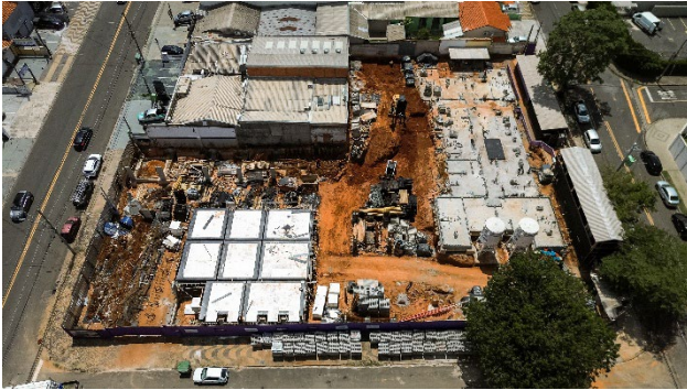
Imagem Aérea – Visão Geral (jan/26) – Execução da laje térreo do edifício residencial e preparação para concretagem do térreo do bloco garagem.
