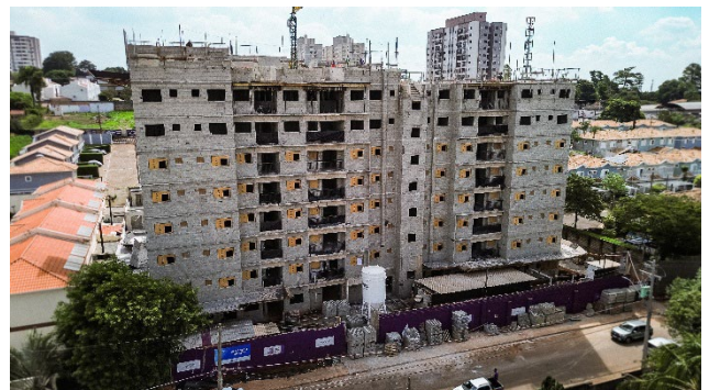
Imagem Aérea – Visão Geral (mar/26) – Execução da alvenaria estrutural do 8º pavimento lado A.
