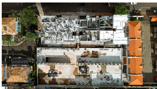
Imagem Aérea – Visão Geral (fev/26) – Execução da alvenaria estrutural do 7º pavimento e preparação para concretagem da laje do 8º pavimento lado A.
