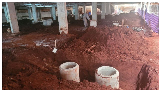
Bloco Garagem (mar/26) – Trabalhos civis no pavimento térreo.
