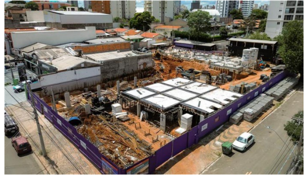
Imagem Aérea – Visão Geral (jan/26) – Execução da laje térreo do edifício residencial e preparação para concretagem do térreo do bloco garagem.
