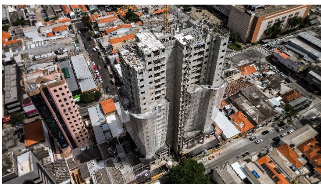
Imagem Aérea – Visão Geral (mar/26) – Preparação para concretagem da laje do 23º pavimento.
