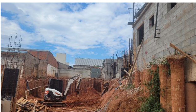
Torre Residencial – Estacas de contenção.
