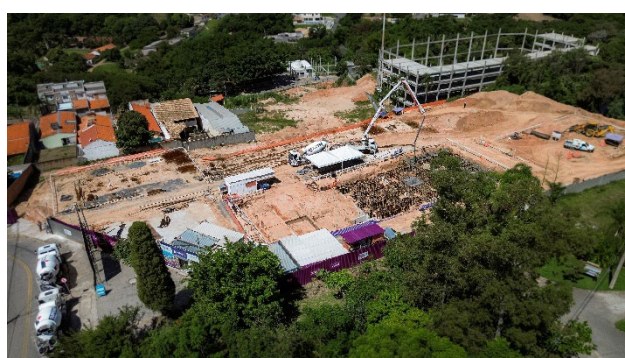
Imagem Aérea – Visão Geral (jan/26) – Execução da fundação da torre residencial e concretagem parcial da área de lazer.
