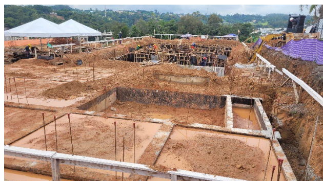
Imagem Aérea – Visão Geral (fev/26) – Execução da fundação.
