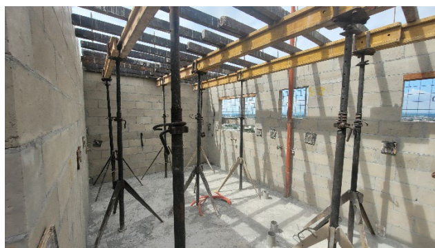
Torre Residencial (mar/26) – Preparação para as fôrmas do 8º pavimento.
