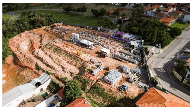
Imagem Aérea – Visão Geral (mar/26) – Execução de embasamento da torre residencial e início da alvenaria da área de lazer.
