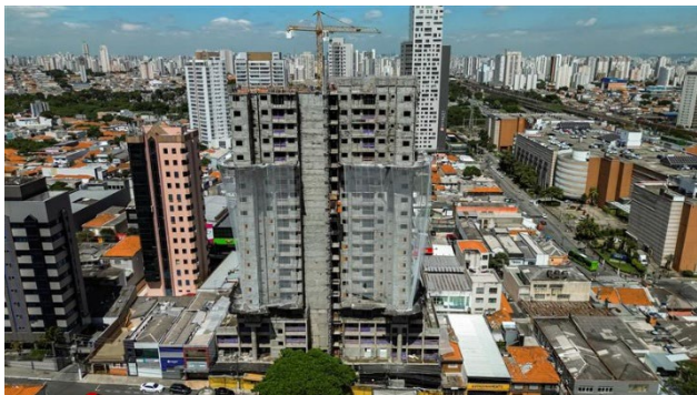
Imagem Aérea – Visão Geral (jan/26) – Estrutura no 21º pavimento.
